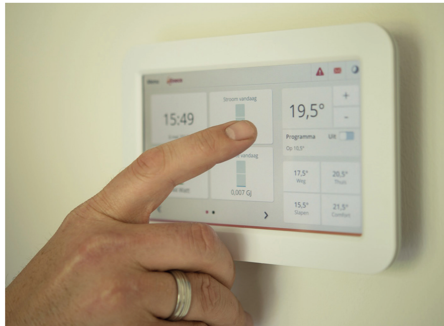
Velmi závažným problémem, který trápí přetápěné domácnosti, je špatná výměna vzduchu v obytném prostoru. Foto redakce
